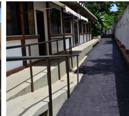
A primeira fase da pista de aceleração já está pronta.
